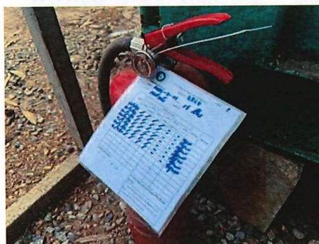
ภาพที่ 46 การตรวจสอบถังดับเพลิง
