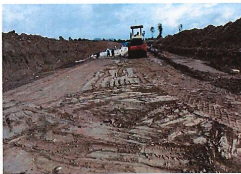
ภาพที่ 3 การบดอัดดิน
